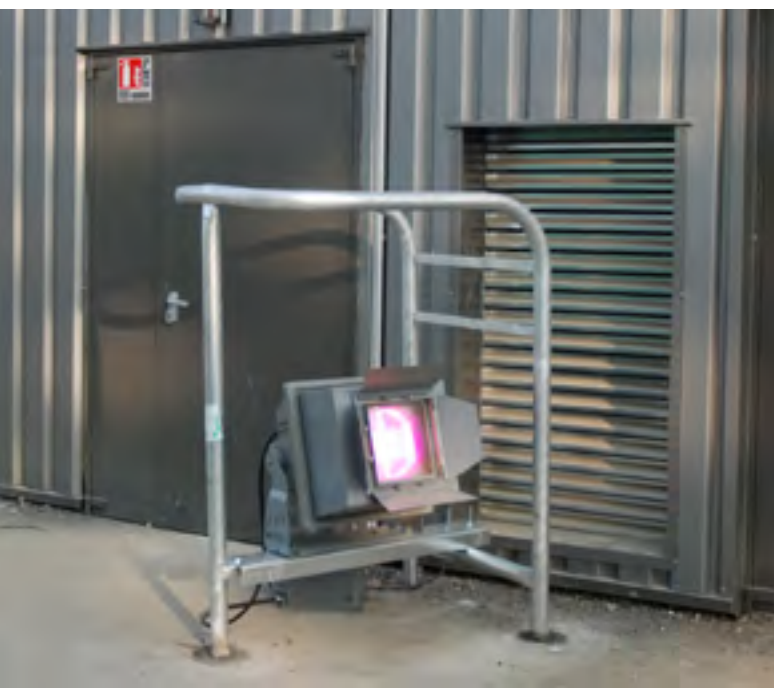
↑ Renforcement des cheminements et luminaire à LED des parkings ↓ Support de protection des luminaires à changeur de couleur de la résille
