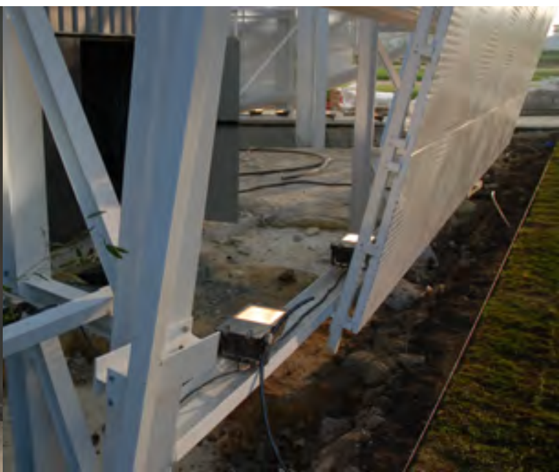
↑ Encastré de sol dans tube tronqué pour le protéger des feuilles et le défilier ↓ Luminaires bon marché derrière la résille des portes d'accès
