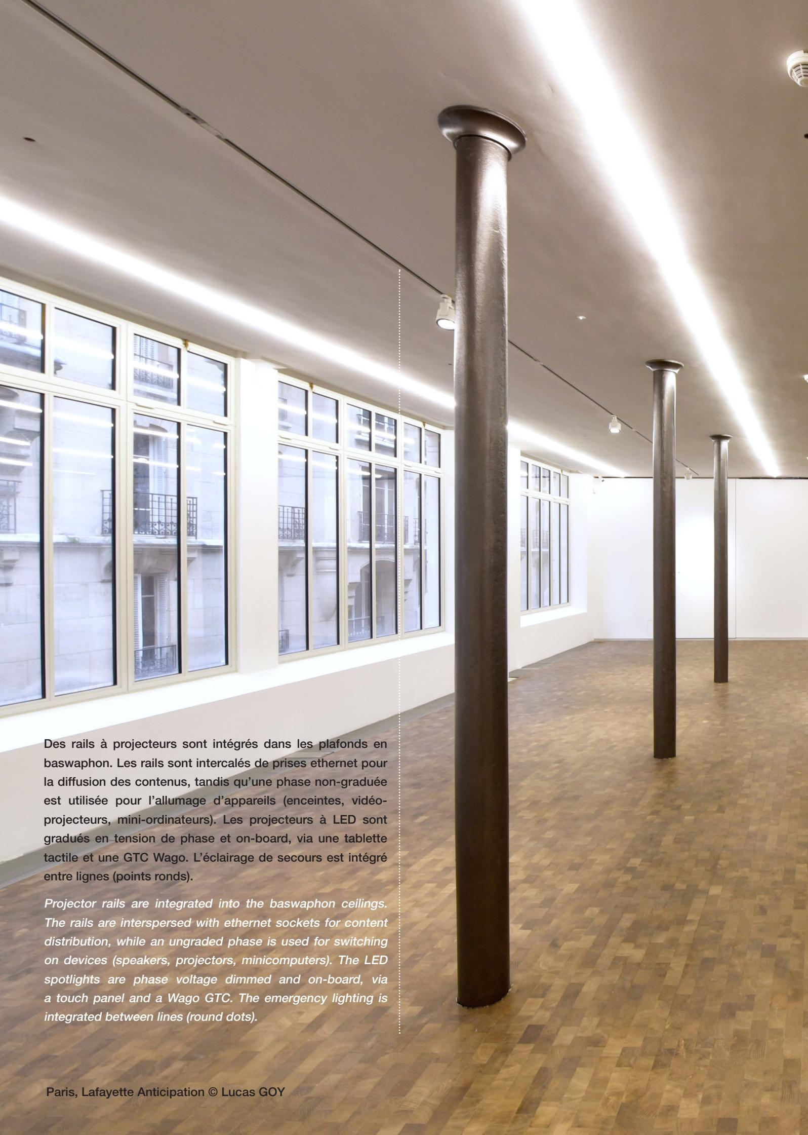
Des rails à projecteurs sont intégrés dans les plafonds en baswaphon. Les rails sont intercalés de prises ethernet pour la diffusion des contenus, tandis qu'une phase non-graduée est utilisée pour l'allumage d'appareils (enceintes, vidéo-projecteurs, mini-ordinateurs). Les projecteurs à LED sont gradués en tension de phase et on-board, via une tablette tactile et une GTC Wago. L'éclairage de secours est intégré entre lignes (points ronds).
